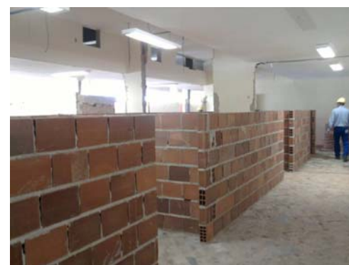
Obras do novo SMS/Saúde
