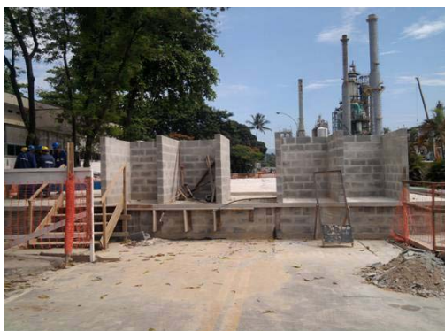
Montagem dos módulos provisórios
